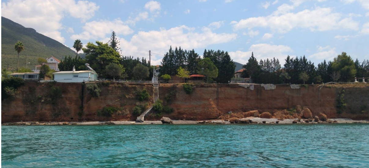
Εικόνα 6-4: Χαρακτηριστική όψη της υπό μελέτης ακτογραμμής. Εμφαίνονται τα απόκρημνα πρηνή, οι καταπτώσεις τεμαχίων και τμήματα χαλικώδους παραλίας. Λήψη από τη θάλασσα
