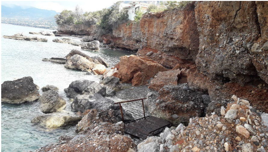
Εικόνα 6-5: Άποψη καταπτώσεων και εκτεθειμένου πρηνούς στην περιοχή μελέτης
