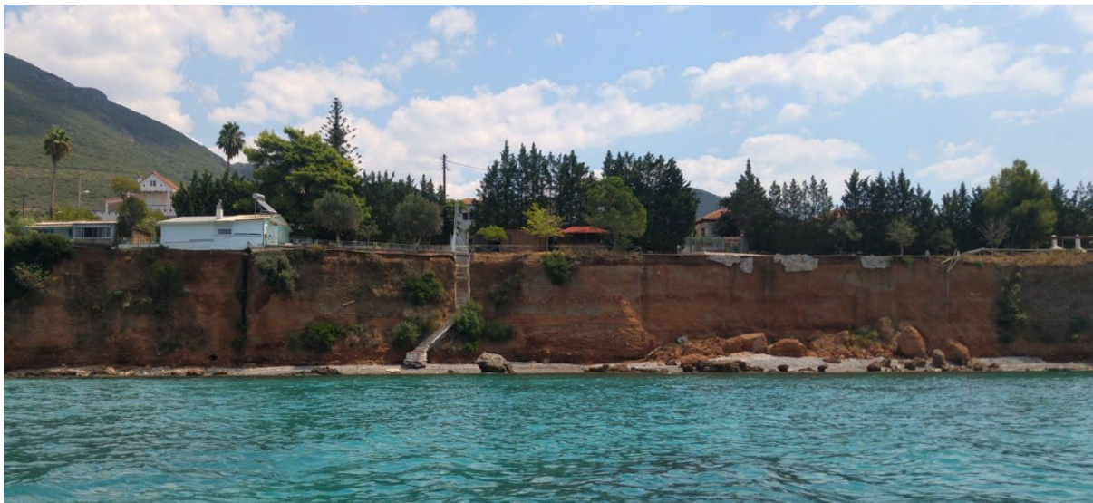
Εικόνα 8-3: Χαρακτηριστική όψη της υπό μελέτης ακτογραμμής. Εμφαίνονται τα απόκρημνα πρηνή, οι καταπτώσεις τεμαχίων και τμήματα χαλικώδους παραλίας. Λήψη από τη θάλασσα
