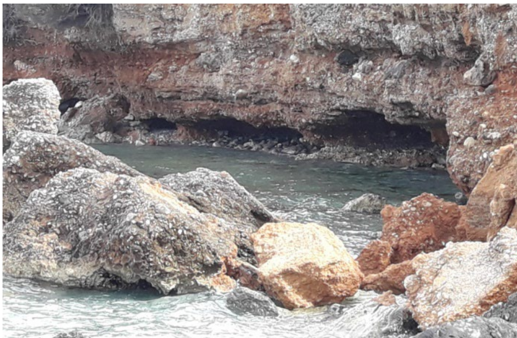
Εικόνα 8-5: Άποψη σπηλαιώσεων του ποδός του πρανούς
