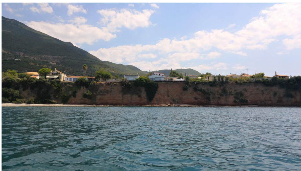
Εικόνα 2: Άποψη από δυτικά του υπό μελέτη παράκτιου μετώπου
