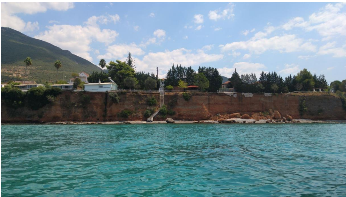
Εικόνα 5: Άποψη από δυτικά του υπό μελέτη παράκτιου μετώπου
