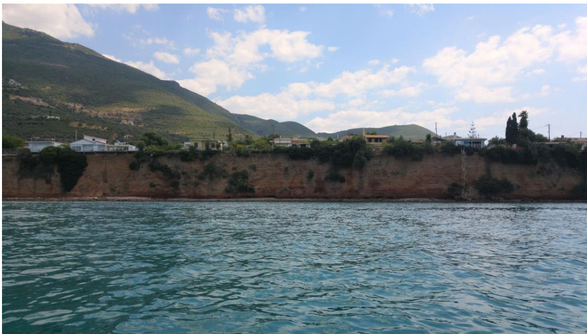
Εικόνα 3: Άποψη από δυτικά του υπό μελέτη παράκτιου μετώπου
