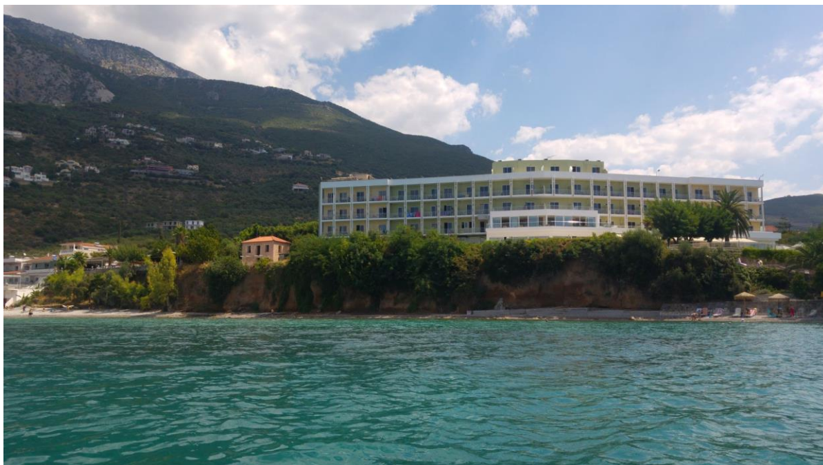
Εικόνα 1: Άποψη από δυτικά του υπό μελέτη παράκτιου μετώπου
