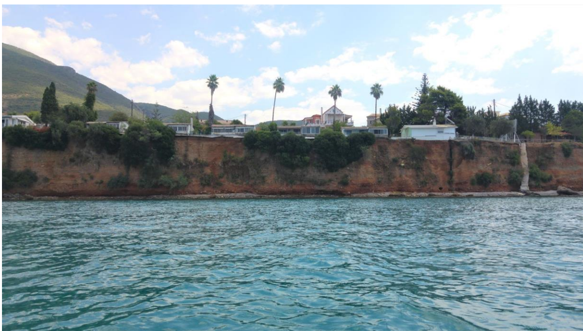
Εικόνα 4: Άποψη από δυτικά του υπό μελέτη παράκτιου μετώπου
