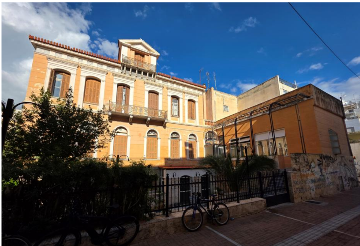
Εικόνα 2: Πίσω όψη κτιρίου
