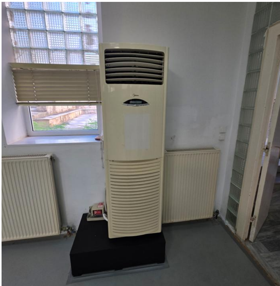
Εικόνα 14. Αερόψυκτη αντλία θερμότητας (α) τύπου split-unit , (β) τύπου κλιματικού ντουλάπας για κάλυψη αναγκών ψύξης
