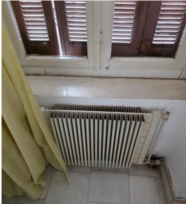
Εικόνα 13. Καλοριφέρ ως τερματικές μονάδες συστήματος θέρμανσης λέβητα, (α) εντός αίθουσας, και (β) στον διάδρομο
