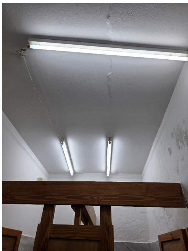
Εικόνα 18. Γραμμικά φωτιστικά φθορισμού
