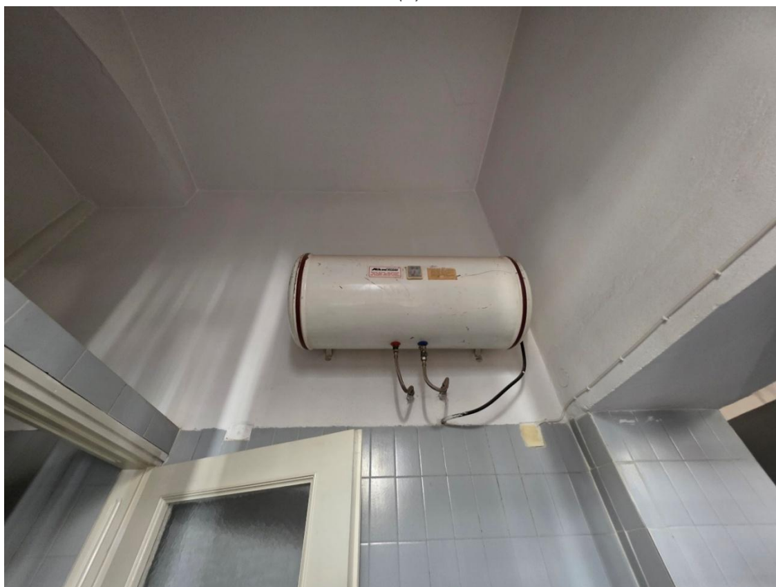
Εικόνα 16. Τοπική ηλεκτρικοί θερμαντήρες παραγωγής ζεστού νερού χρήσης
