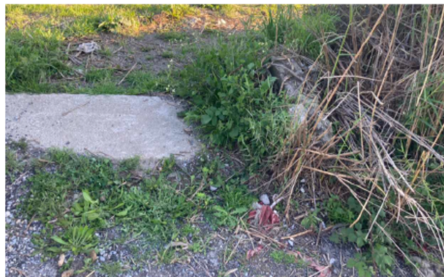
Άποψη της απόληξης στο σύνορο της όμορης ιδιοκτησίας.
