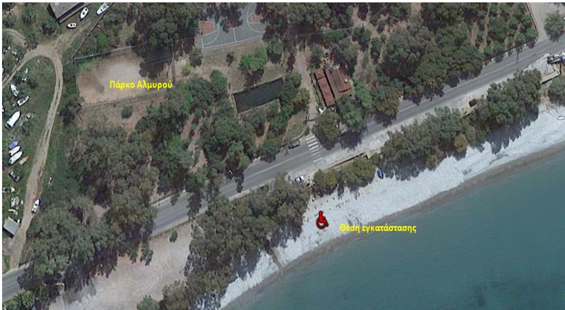
Εικόνα 5: Θέση εγκατάστασης στην περιοχή Αλμυρού
