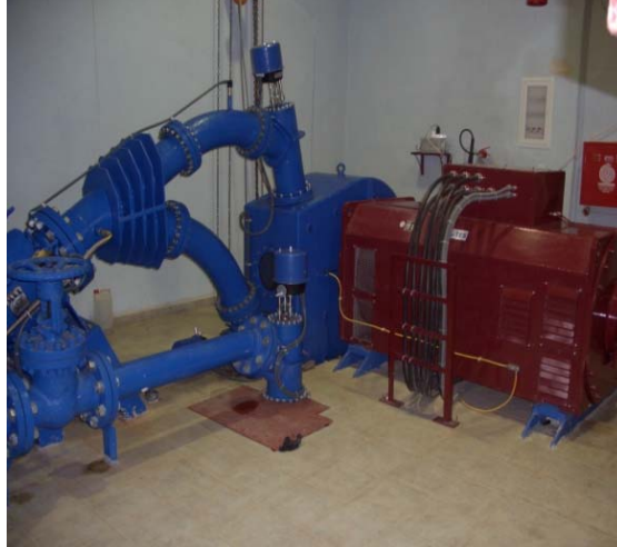
Εικόνα 6: Εγκαταστημένο σύστημα Pelton (μπλε ο στρόβιλος, κόκκινο η γεννήτρια)
