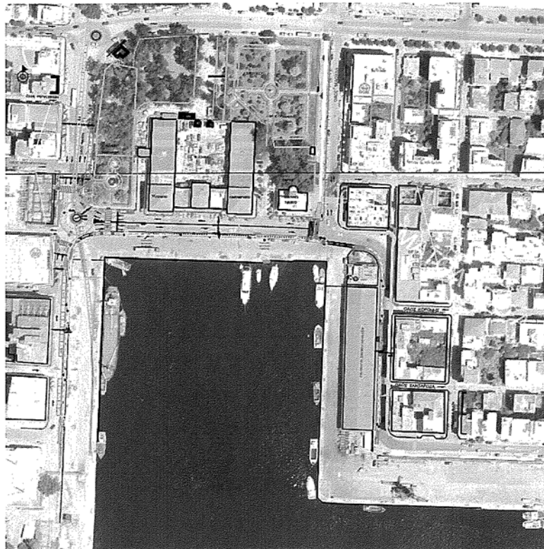
Εικόνα 2: Γενική άποψη επεμβάσεων.
